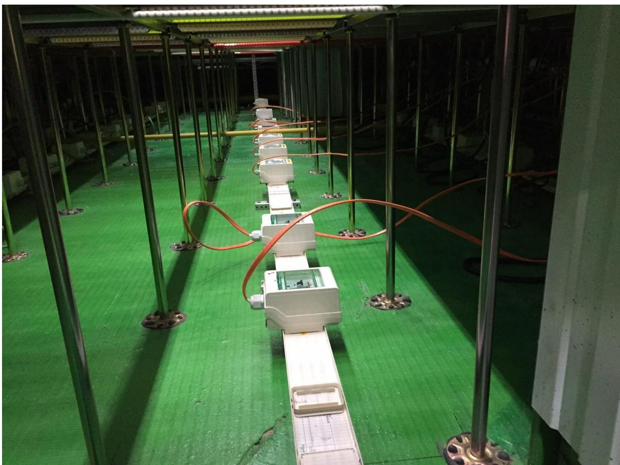
*На шинопроводе устанавливаются отводные коробки с автоматами, ведущими к стойкам.*
