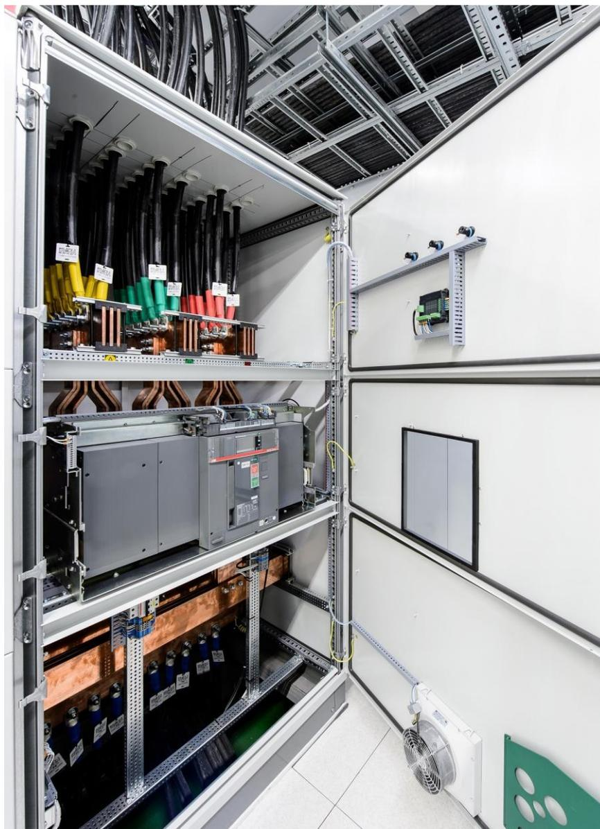
*В верхней части расположены кабели, по которым приходит электричество из трансформатора. В средней части — вводной автомат, внизу медная распределительная шина.*
