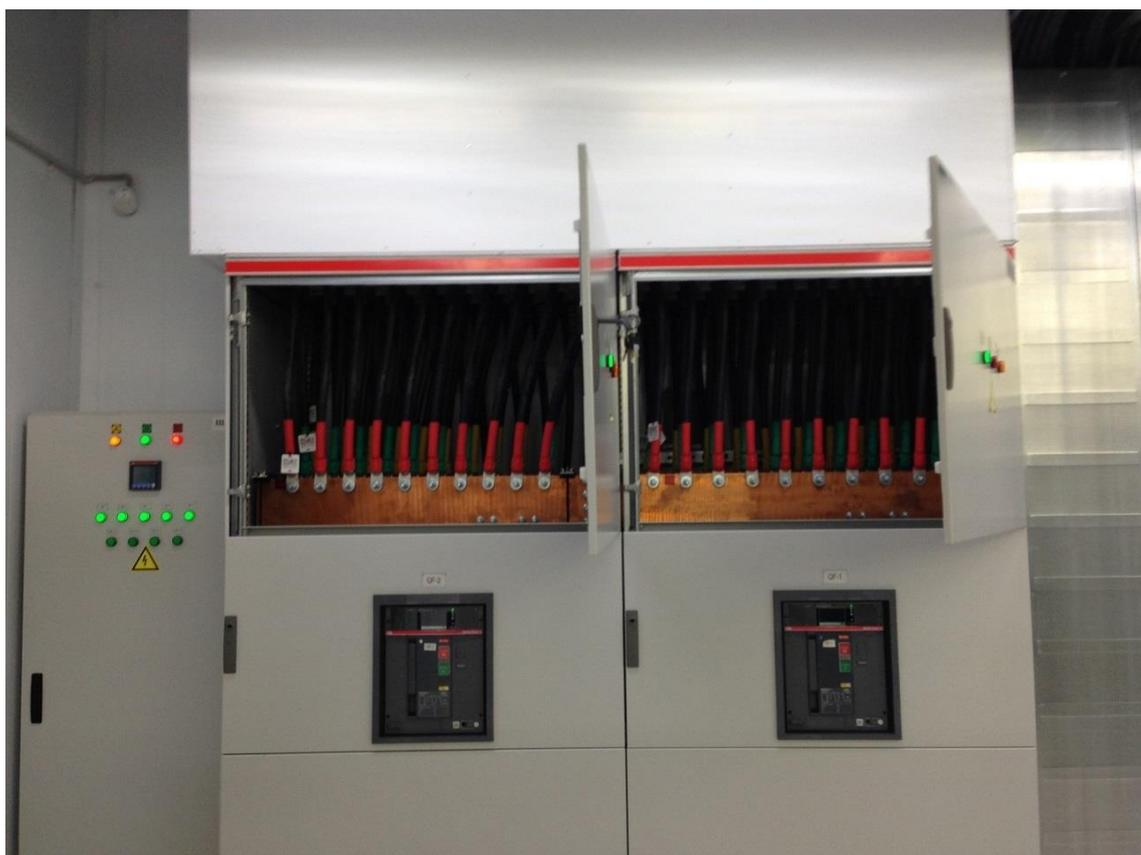
*Все вырабатываемое ДГУ электричество поступает на медную распределительную шину и оттуда идет на вводной автомат от ДГУ.*
